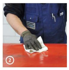
Achten Sie darauf, dass kein Schmutz, Fett, Öl etc. auf der Oberfläche zurückbleibt. Achten Sie darauf, dass die Oberfläche völlig trocken ist, bevor das Klebeband angebracht wird.
