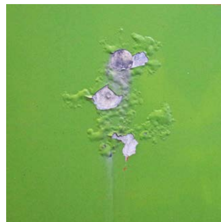
Lakschade ontstaan door beschadigingen aan de binnenwanden
