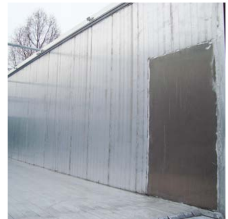
Slijtplaten aan de binnenwand.
